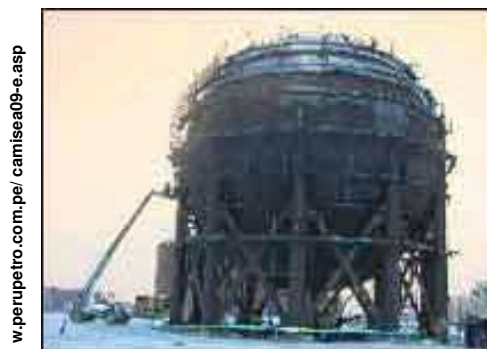
Figura 3.9: Construção de reservatórios para os hidrocarbonetos.
