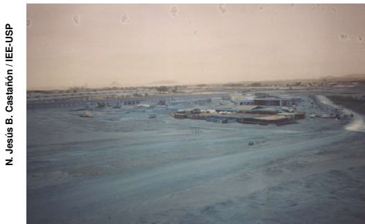
Figura 3.11: Construção de instalações comerciais do city gate.
