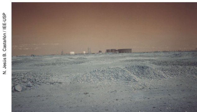
Figura 3.8: Construção da planta de fracionamento de LGN, novembro 2003.
