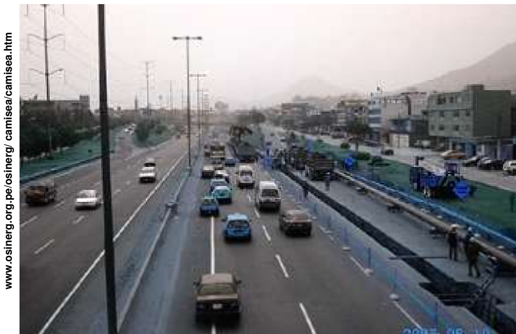
Figura 3.13: Obras em média pressão dos gasodutos na cidade de Lima.
