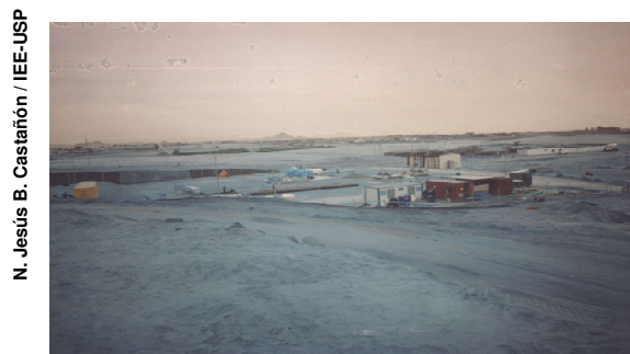
Figura 3.12: Ingresso do GN ao city gate, novembro do 2003.
